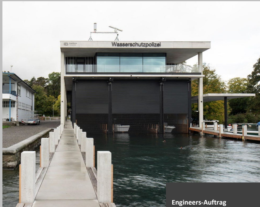
Bild: E2A Architekten AG
